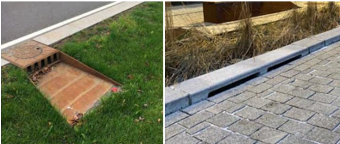
Figur 4: Eksempel på "kjeftsluk" i kantstein som leder overvann til grøntområder langs veg.
